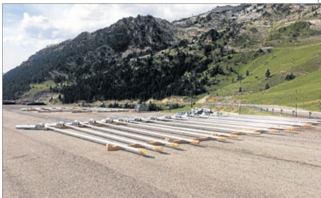
Materials al pàrquing de la Bonaigua per a la nova xarxa d'innivació artificial de Baqueira.
