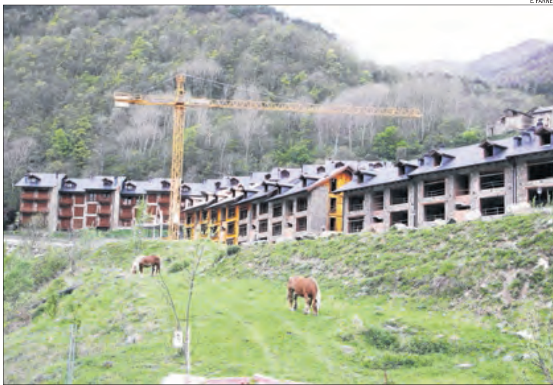
Imatge d'arxiu dels primers pisos construïts a Espui en el marc del projecte del resort.
