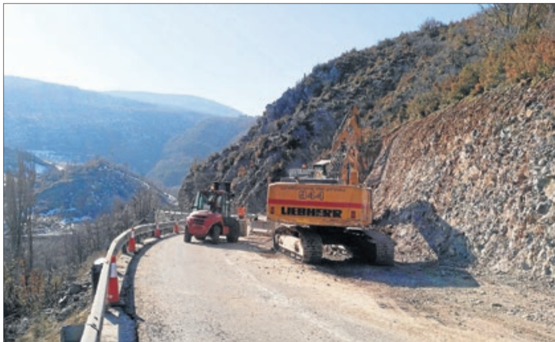
Imatge d'unes obres que s'executen a l'N-260 entre el Pont de Suert i Xerallo.
