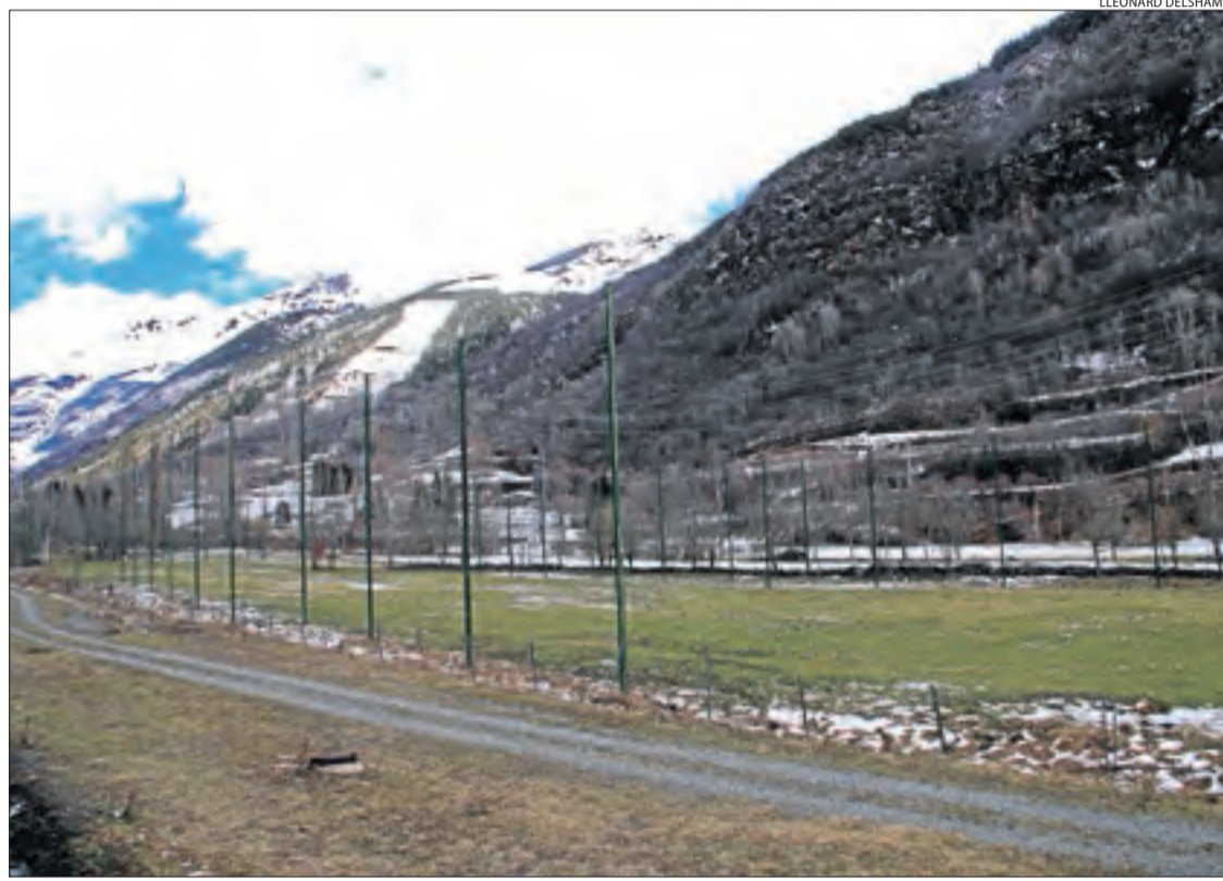
Els terrenys del camp de golf, construït fa una dècada i que mai va arribar a funcionar.
