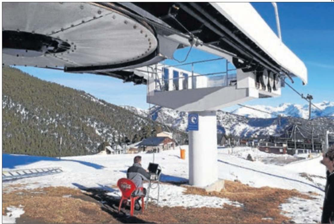
Treballs per comprovar l'estat del telecadira la Roca d'Espot, la setmana passada.
