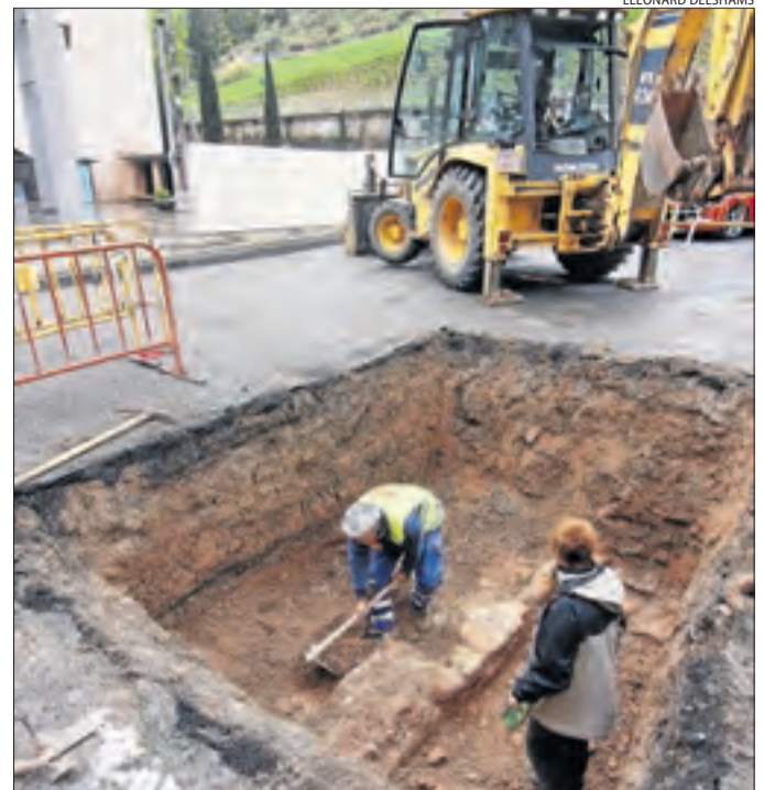
Imatge d'un dels sondatges ahir al pàrquing de l'Auditori.
