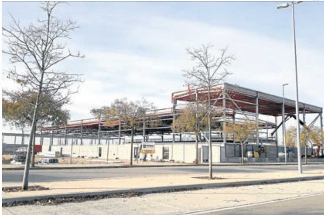
Imatge de la construcció de l'obrador del grup Teresa Carles al polígon industrial Vinyes del Mig.
