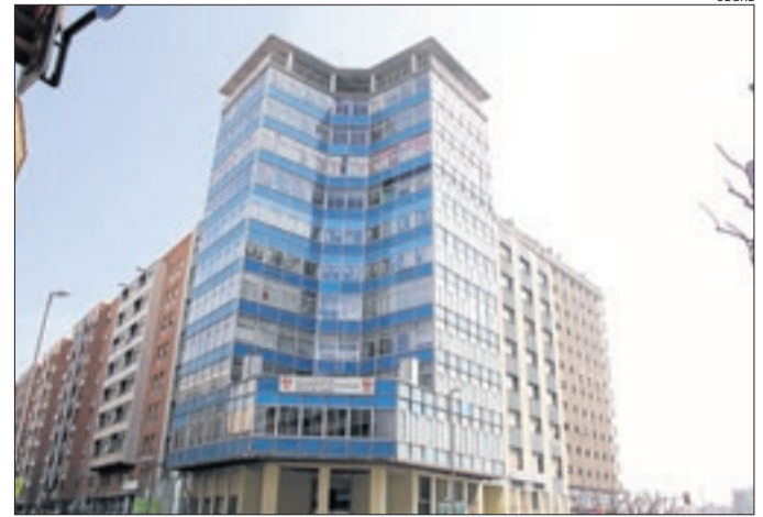
A l'edifici dels sindicats només queda UGT.
