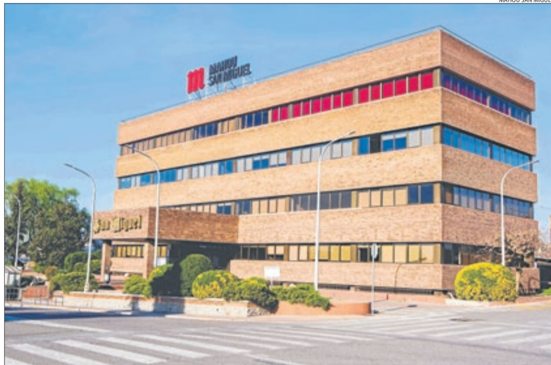
Instal·lacions de Mahou San Miguel a Lleida.
