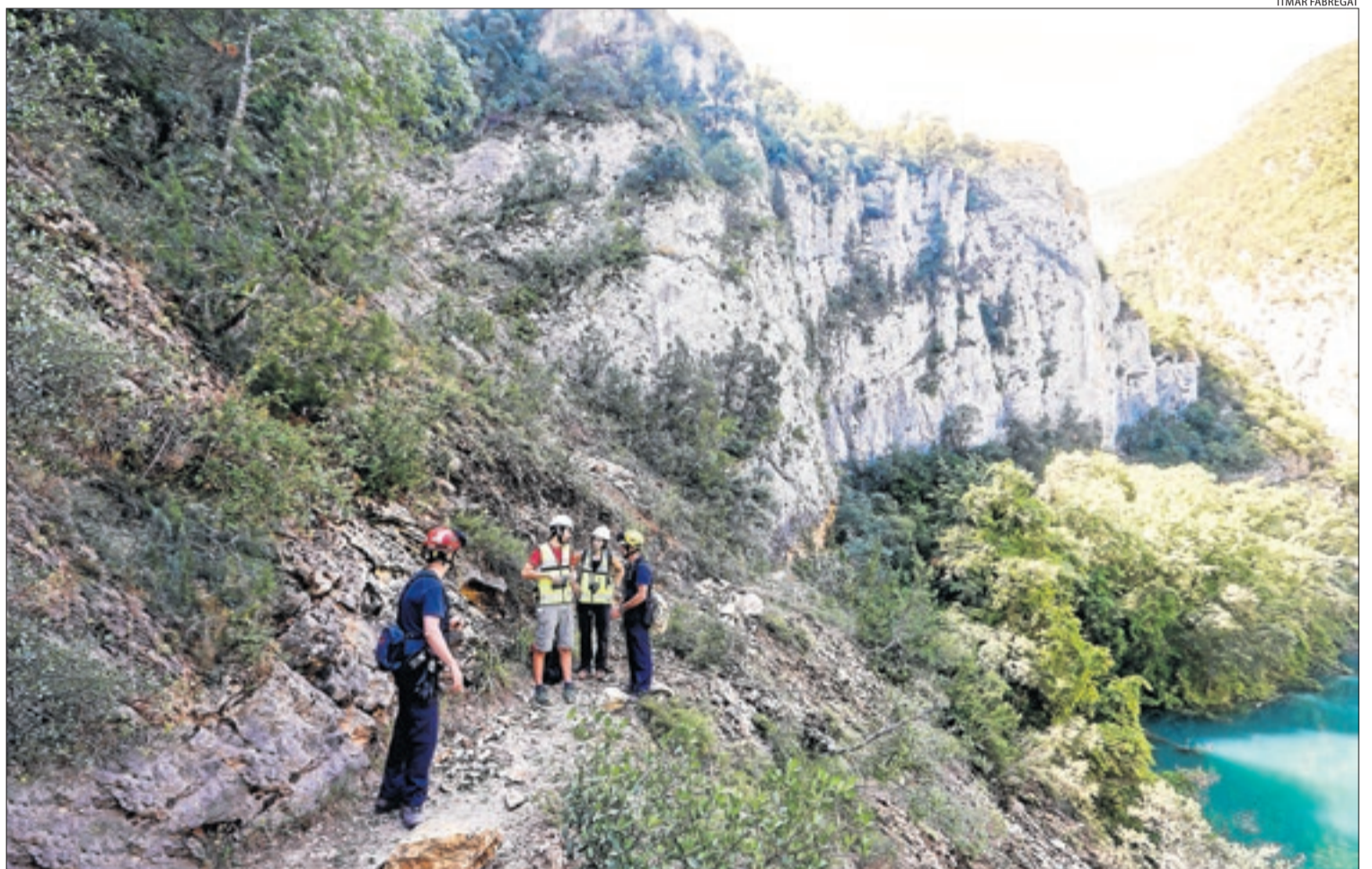
Bombers i geòlegs de l'ICGC van inspeccionar la zona per saber l'envergadura del despreniment.
